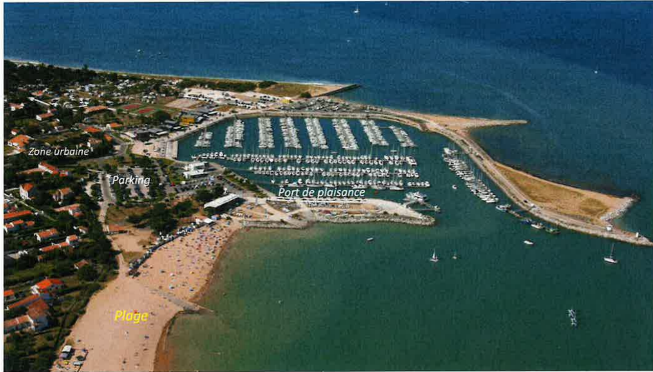
Vue aérienne du site : Un parking à l'interface du bourg, du port et de la plage
