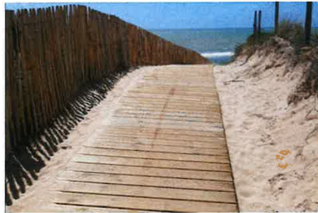
Platelage bois démontable (Source : CDCIO)
