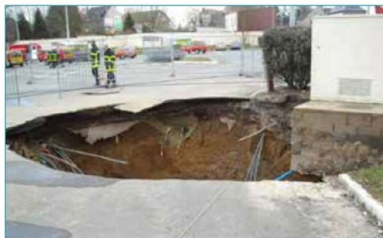
Illustration 1.27 : Effondrement de chaussée, Bapaume (62) [crédit BRGM, sd]
